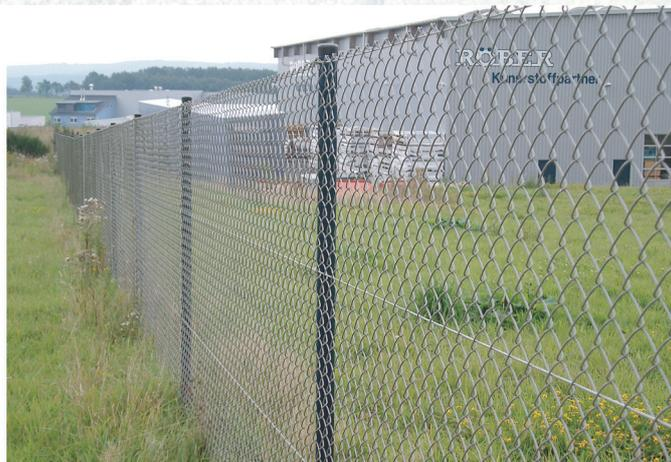
**Sinterfil-Geflechte:** bestehen aus verzinkten Stahldrähten, auf denen eine Kunststoffschicht aufgeschmolzen wird, die sich weder verschieben noch abstreifen lässt und widerstandsfähig gegenüber UV-Strahlung ist (Standardfarbe: RAL 6005 moosgrün, RAL 7030 steingrau).
